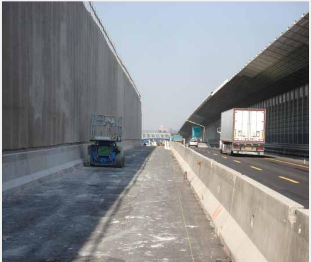
Tra i tanti vantaggi dell'applicazione dell'intonaco fonoassorbente in particolare due sono risultati determinanti nella scelta finale: l'assoluta assenza di detriti pericolosi in caso di impatto con un veicolo e l'estrema facilità di ripristino a seguito di incidente, grazie alla possibilità di utilizzare le piattaforme aeree che vengono calate dalla sommità della galleria, senza la necessità di bloccare il traffico.
